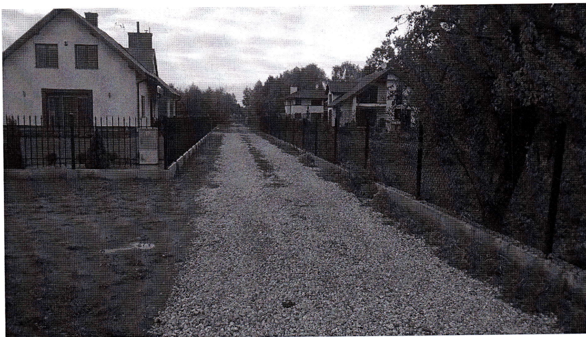
Fot 1. Widok drogi wzdłuż której projektowane jest oświetlenie
