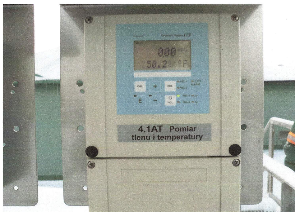
Rys. 6. Fotografia wskazań sondy tlenowej w komorze niedotlenionej 2
