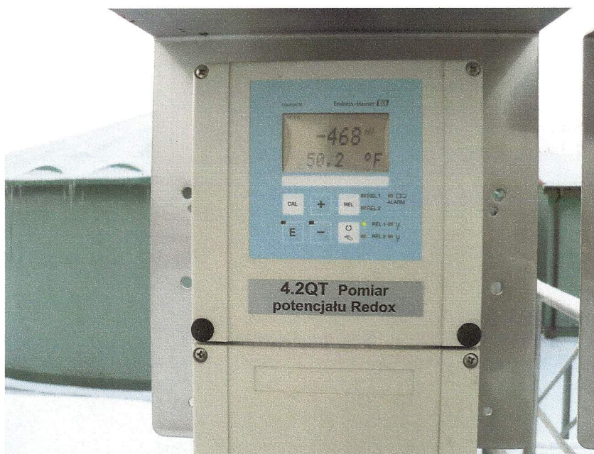
Rys. 7. Fotografia wskazań sondy Redox w komorze niedotlenionej 2
