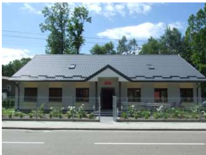
Rysunek 21 Nowa siedziba zakładu komunalnego w Halinowie
