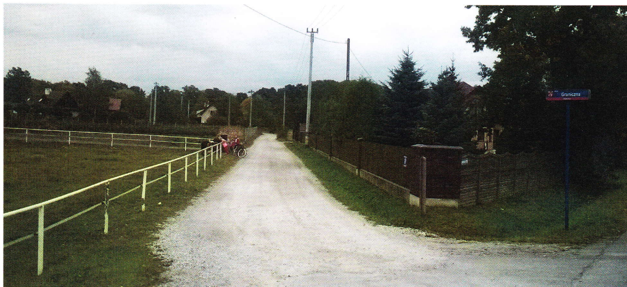
Rysunek 1. Widok drogi wzdłuż której projektowane jest oświetlenie
