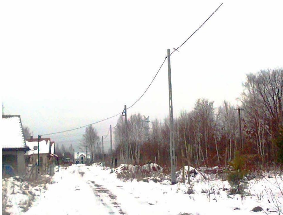
Widok ul. Cynamonowej ( w kier. torów PKP)
