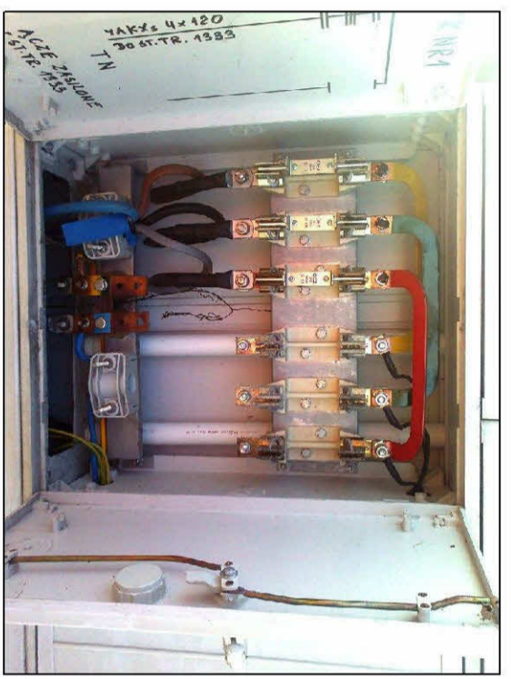
Widok istniejącego ZK2
