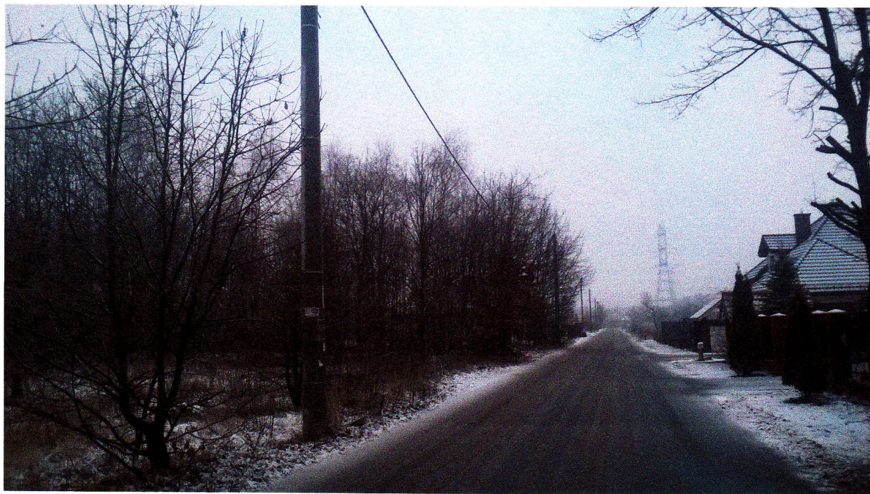
Rysunek 1. Widok drogi wzdłuż której projektowane jest oświetlenie
