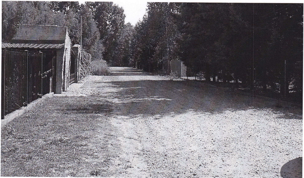
Fot 1. Widok ulicy wspólnej, wzdłuż której projektowane jest oświetlenie
