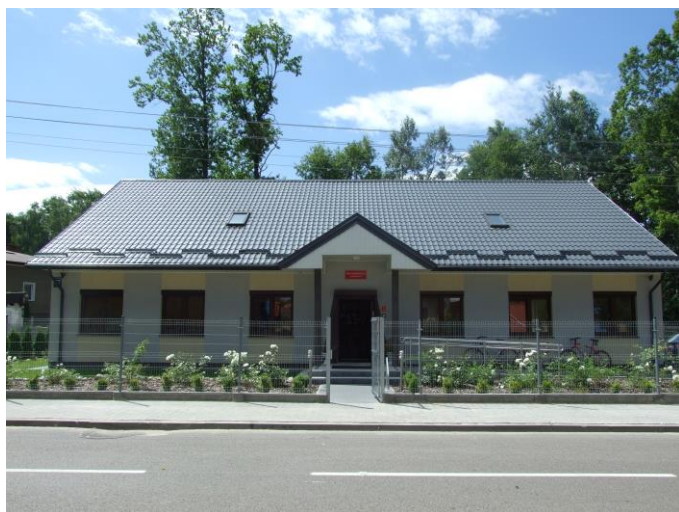
Rysunek 21 Nowa siedziba zakładu komunalnego w Halinowie
